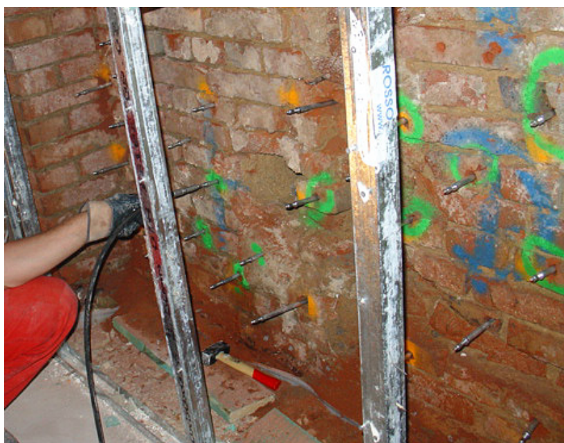
Obr 23. Plošná injektáž [5]
