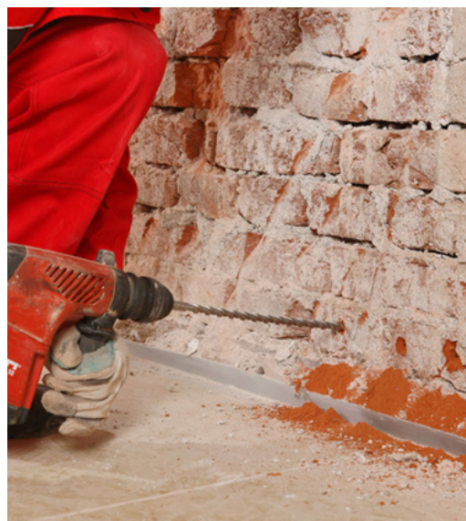
Obr 18. Provádění injektážních vrtů [5]
