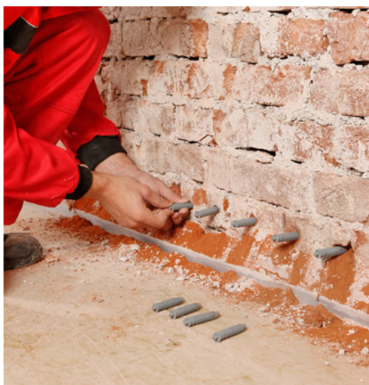
Obr 20. Osazení pakrů na vrty [5]
