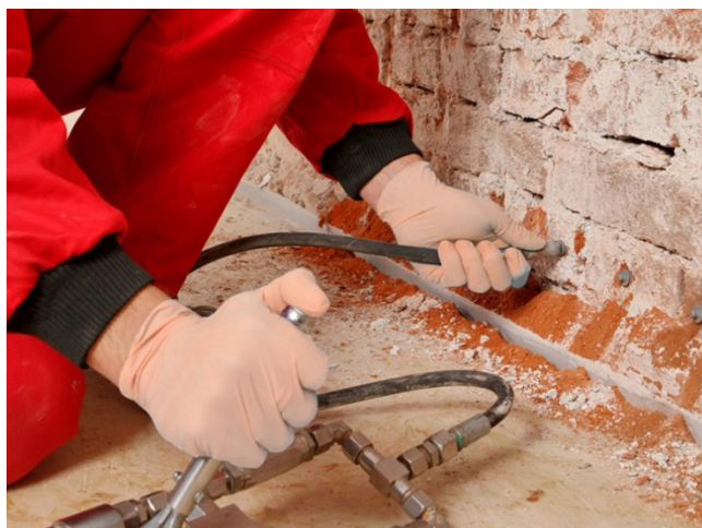
Obr 21. Osazení pakrů talkovým zařízením [5]
