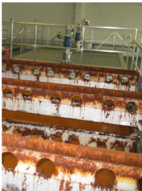
Obr.4 Flotace použitá na ÚV Mostiště v rámci havarijních opatření (foto Slavičková)
