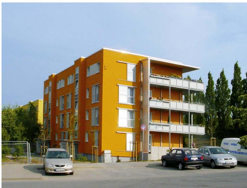
Obrázek č. 1: Objekt v Drážďanech, původní počet podlaží 6NP, sníženo na 4NP.
